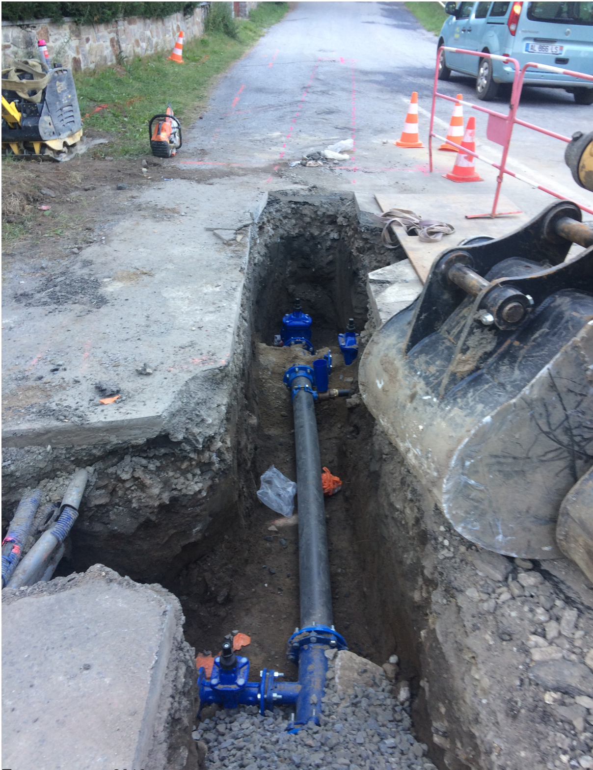
Travaux de pose des conduites d'égout (égout) et de la pose
